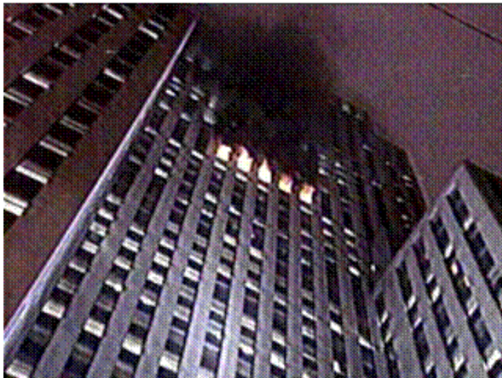
LaSalle Bank Fire – Chicago, IL
